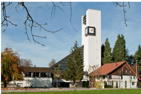
Kirche im Wil Fällandenstrasse 1
