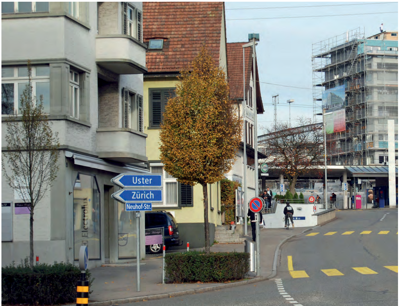
Blick zum Bahnhof Dübendorf mit Neubau «Insiderpark»
