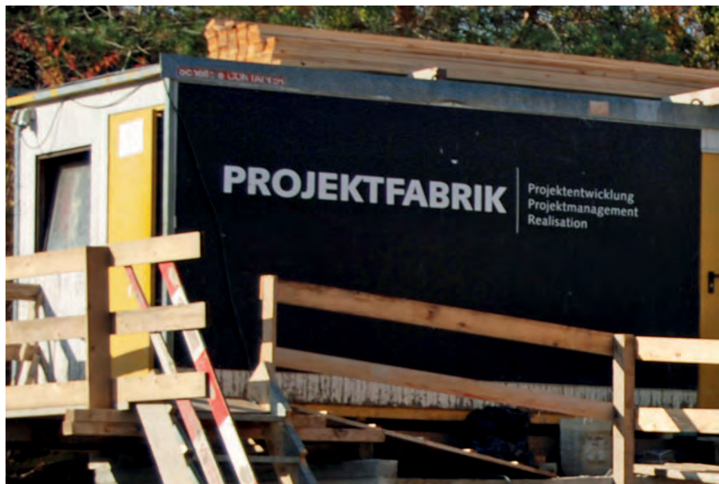
Baustelle Böszelgstrasse, Stettbach
