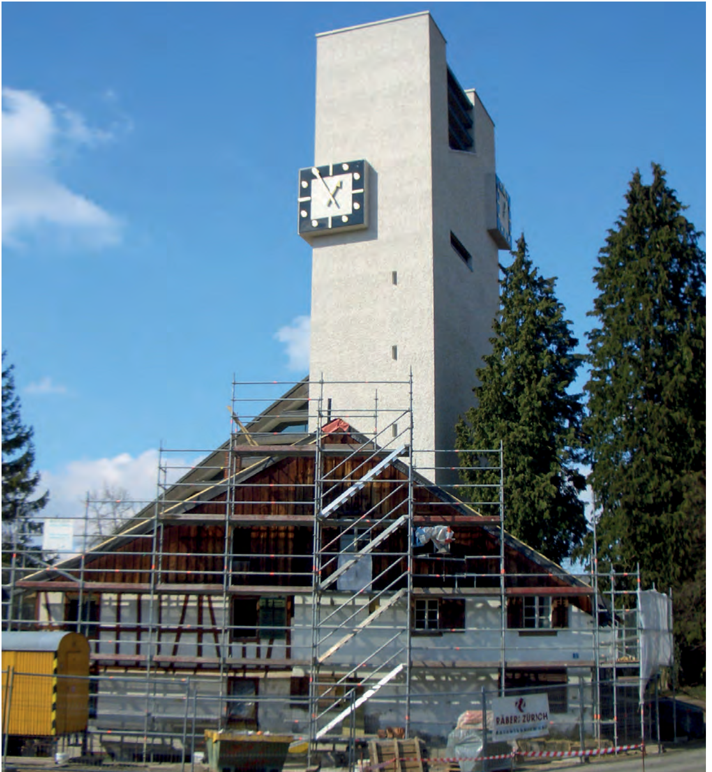
Renovation «Schenkel-Haus» bei der Kirche im Wil
