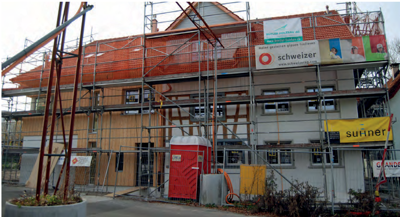
Um- und Erweiterungsbau Meiershofstrasse Dübendorf
