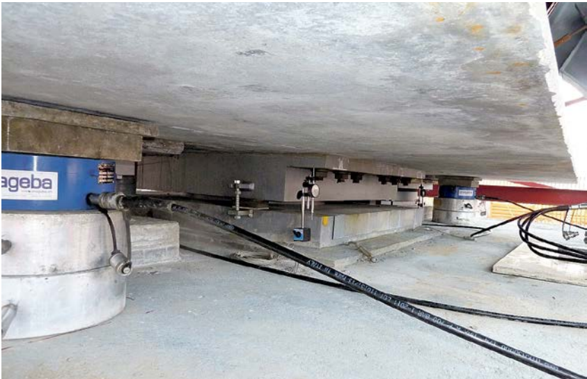
Hebeintervention an einer Stütze
